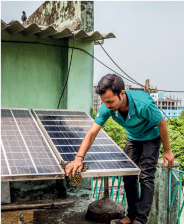
Reinigung der Solarzellen auf dem Dach des ONergy-Gebäudes im indischen Kalkutta (offiziell Kolkata). Unter dem Markennamen ONergy vermarktet der Oikocredit-Partner Punam Energy Private Limited seine Produkte.
